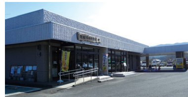
店舗入口のバリアフリー化(スロープ整備)
